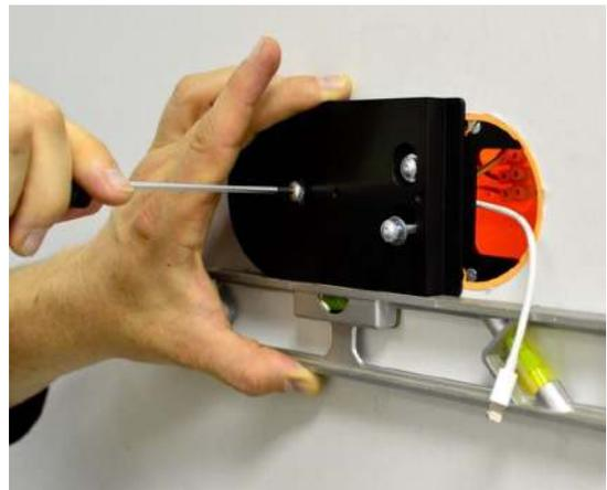
**Schritt 2 ! Optional:** Die Montageplatte bietet Ihnen auf der linken äußeren Seite ein weiteres Befestigungsloch. Dieses sitzt außerhalb der Dose direkt auf der Wand und verleiht dem free bei Bedarf zusätzliche Stabilität.
